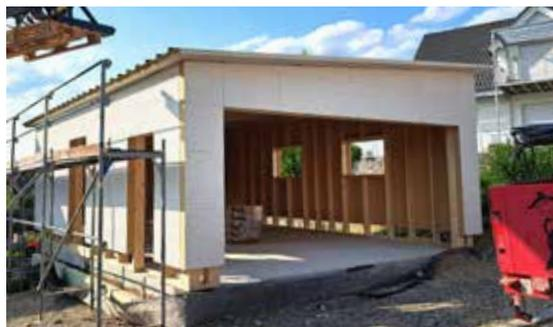
Durch die Herstellung von Fertigteilen von Holzständerwänden und Dachelementen verringert sich die Bauzeit auf der Baustelle.
